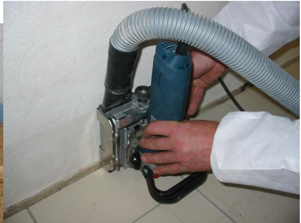
Freilegen der Fuge
