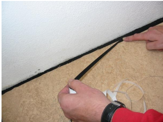
Selbstklebendes Hakenband zur Fixierung des Filtergewebes
