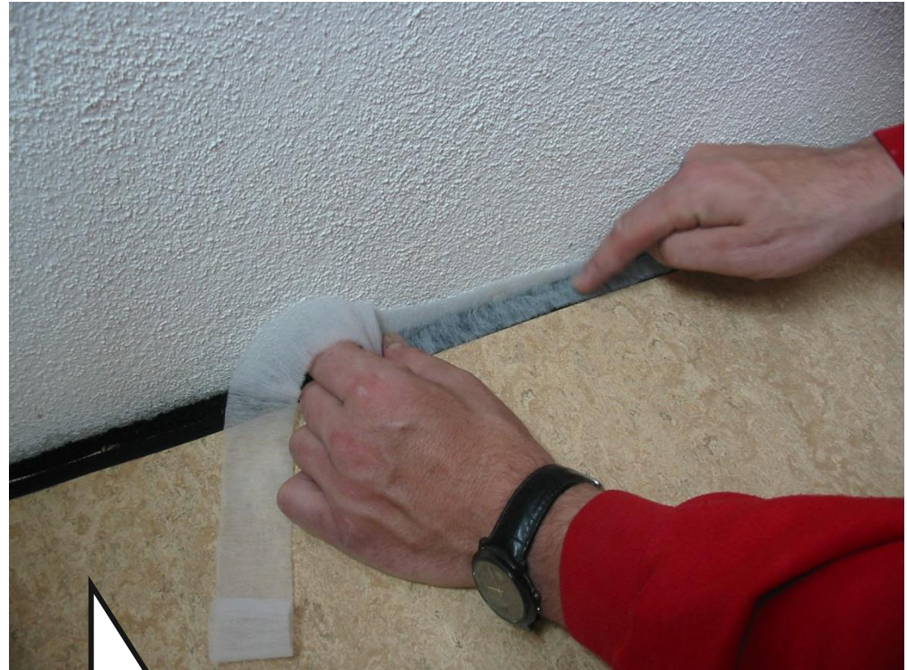
Befestigung der Membran zur Staubfilterung
