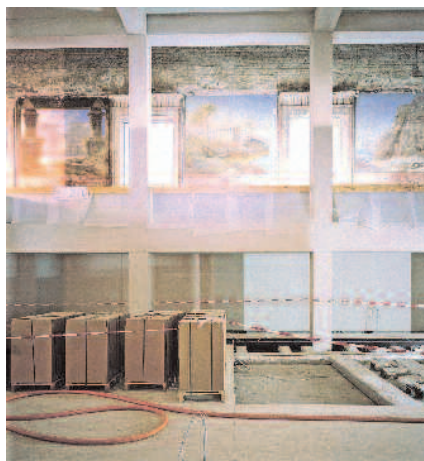
Das Pergamonmuseum wird schrittweise mit modernen Bodensystemen ausgestattet
