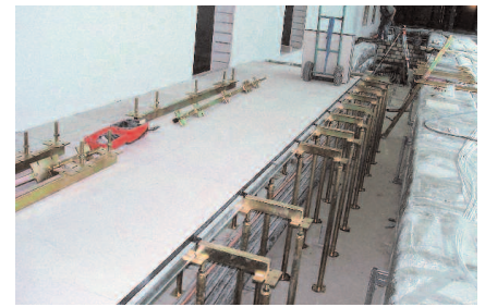
Innenansichten eines Doppelbodens bei großer Aufbauhöhe
