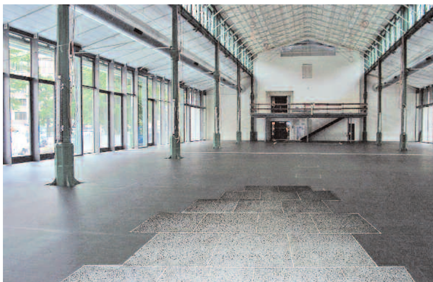
Für die Schrennhalle in München waren die planerischen Vorgaben unter anderem hohe Lasten aus Publikumsverkehr, Marktständen und dynamisch beweglichen Lasten durch Hubwägen
