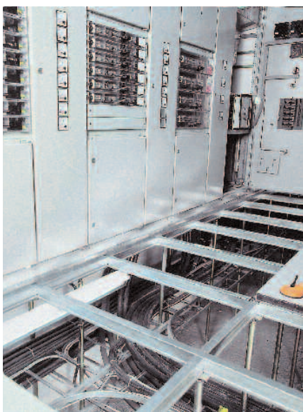
Schaltwartenkonstruktion bei großer Aufbauhöhe
