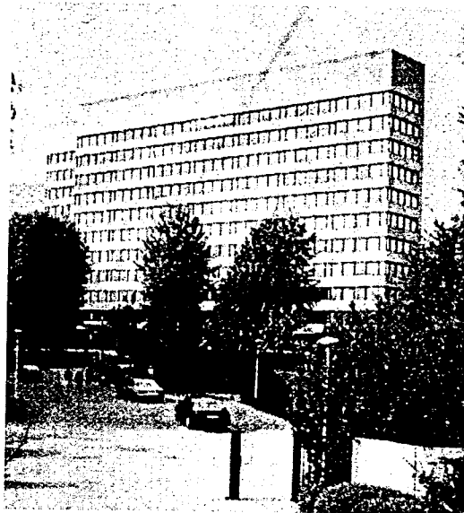
Abbildung 5.1-1: Außenansicht des Gebäudes
