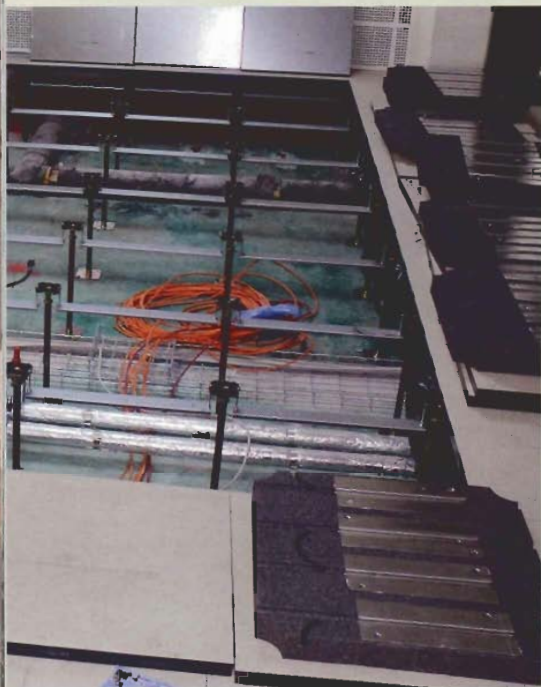
Start. Vorbereitung der Unterkonstruktion für die Auflage der Wärmedämmkassetten auf Trägerprofilen zwischen den Stützen
