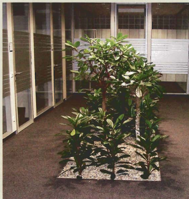
Endzustand. Raumgestaltung im Innenausbau mit einem Doppelboden: Pflanzkübel mit Hydrokulturen höhengleich mit der Bodenebene eingebaut
