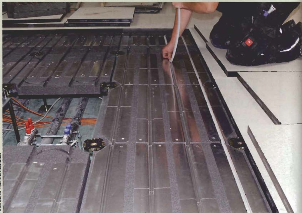
Wärmeleitbleche. Verlegen der hochdruckvernetzten Polyethylenrohre für die Heiz- und Kühlkreisläufe in den Wärmedämmkassetten
