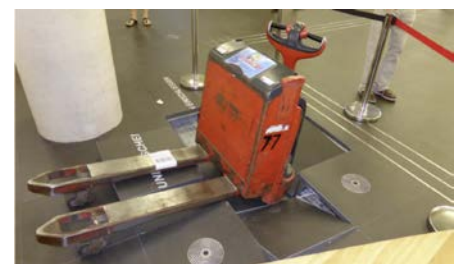
(5) Überbelastung durch einen Elektrohubwagen
