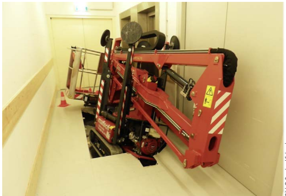
(7) Überbelastung durch einen Hubsteiger
