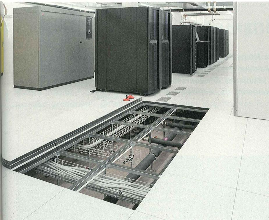
Räume mit vielen anzusteuern den technischen Einheiten empfehlen sich für Doppelböden, die an jedem beliebigen Punkt geöffnet werden können.
