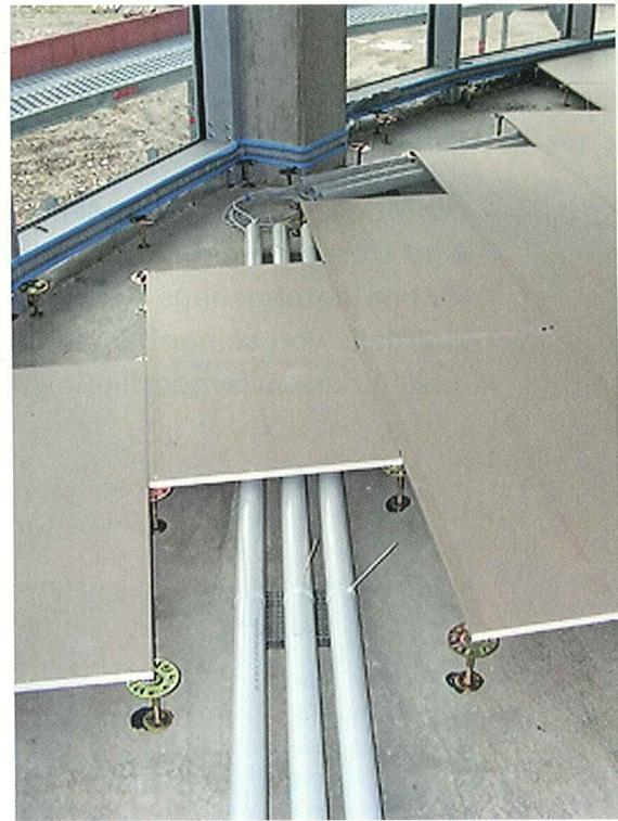
Flächen für Büros, Verwaltung, Kommunikation werden meist in Form von Hohlböden ausgeführt. Als Tragschicht wird ein Anhydrit-Estrich auf eine abdichtende Folie verwendet.
